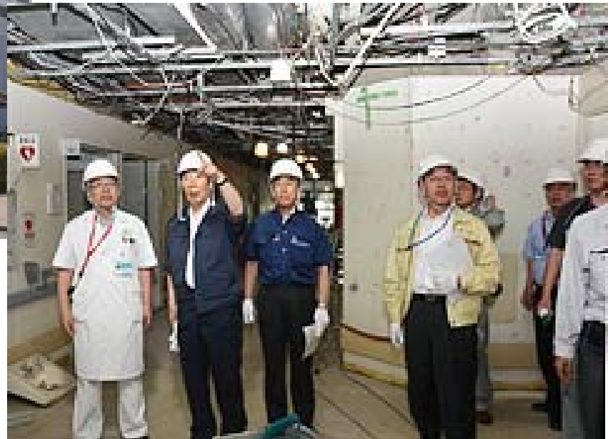
釜石病院の耐震化工事を説明する遠藤院長(左)
