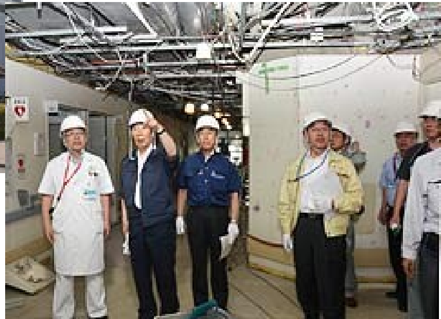
釜石病院の耐震化工事を説明する遠藤院長(左)
