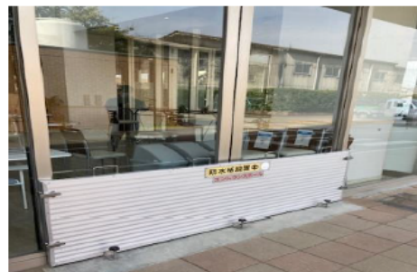
(止水板の設置)
